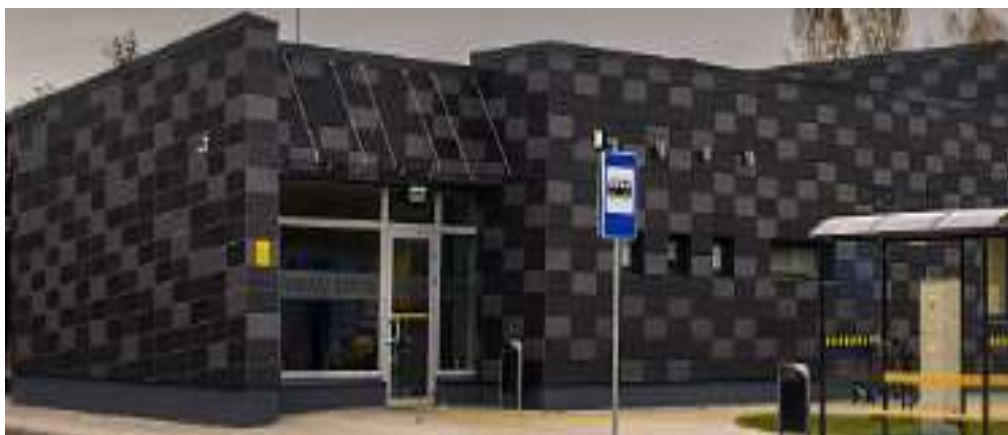
1 pav. Naujosios Akmenės autobusų stotis
